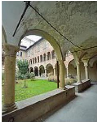
Il cortile all'interno del complesso di via Tasso: verrà sistemato
